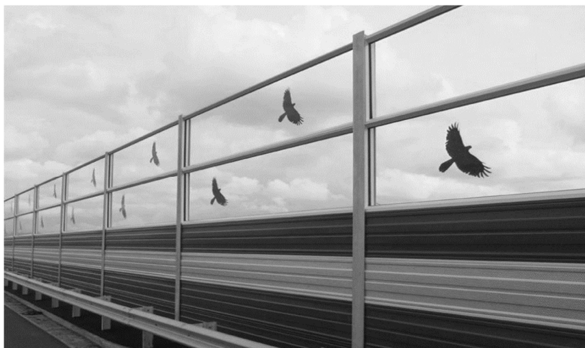
Пример шумозащитного экрана с нанесением изображения хищных птиц на прозрачные участки панели
